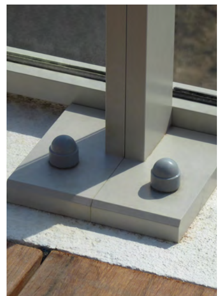
Vue intérieure / Détail du sabot.
