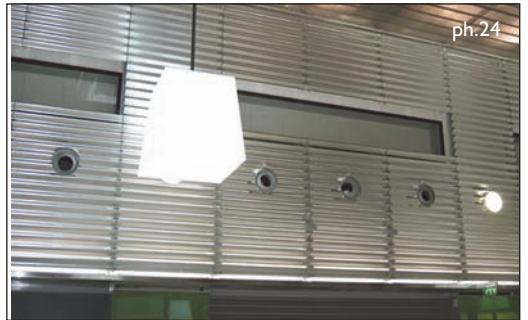
Aéroport Roissy (95) - Terminal 2E
